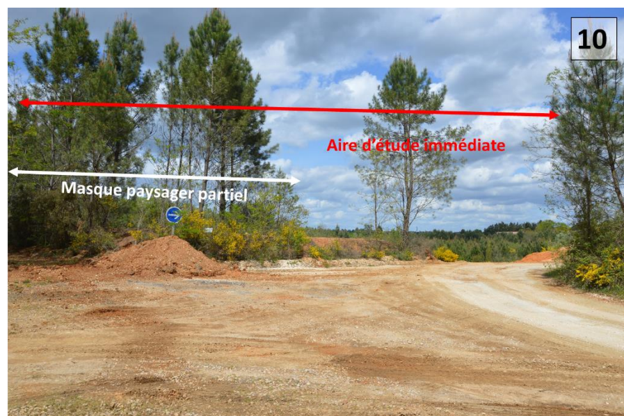
Vue depuis l'entrée de la carrière en activité : visibilité éloignée partielle Végétation formant un masque paysager partiel depuis l'entrée de la carrière. Le point haut de l'AEI et les arbres existants sont visibles de manière éloignée depuis l'entrée du site.
